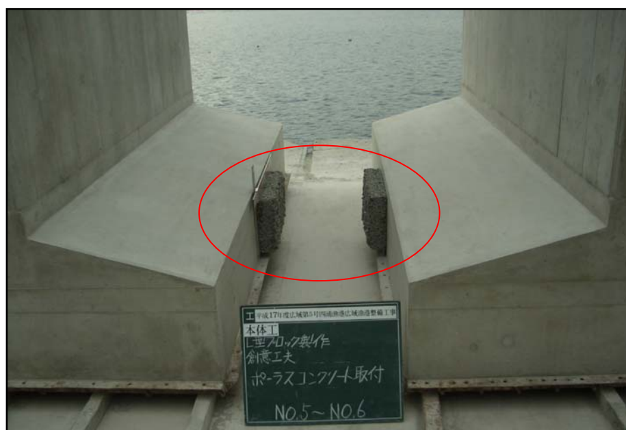
【 海中部に据付けるL型擁壁への設置状況】
